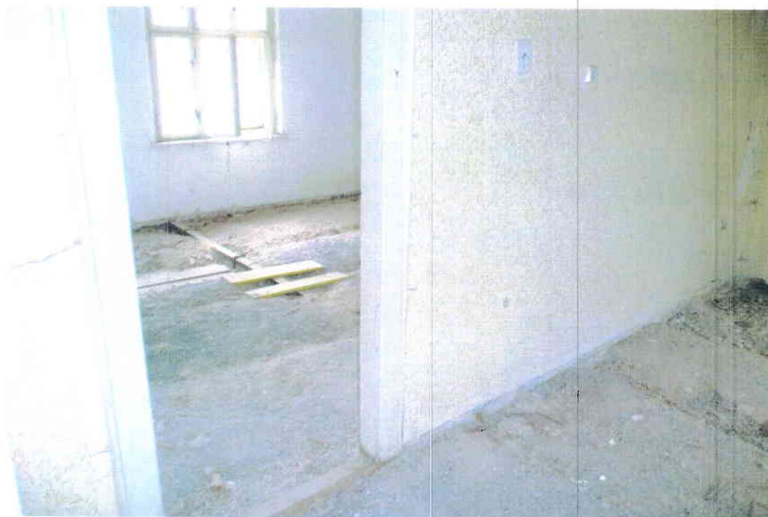
Místnost v patře – zásyp na cihelných klenbách „do travers“
